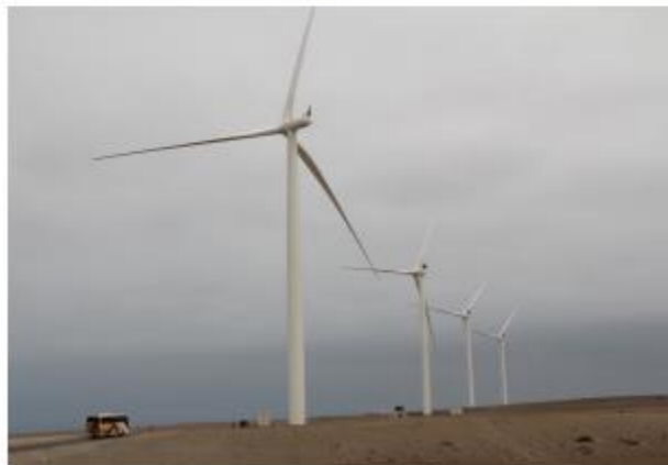
Talara (30 MW) Energía Eólica S.A. en Piura
